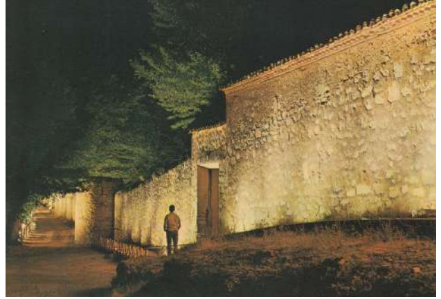
Figura 15: 41.- MONASTERIO DE PIEDRA. (Zaragoza). Murallas. Aspecto nocturno. 1969.
