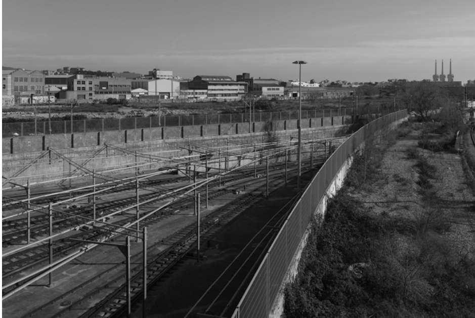
Figura 16: El triángulo ferroviario (Lonas de la desembocadura 3)
