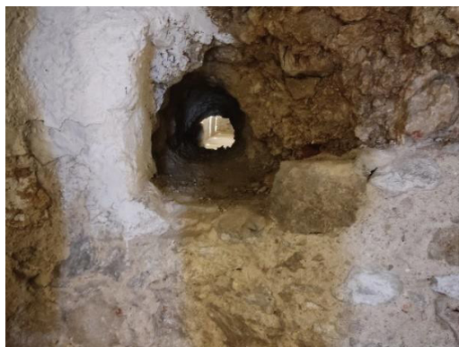
Detalle de una tronera
