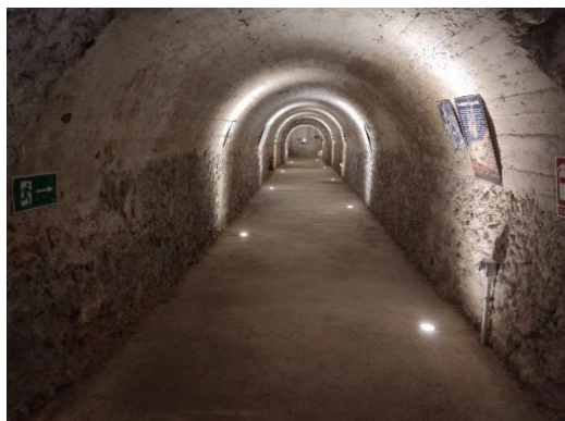
Vista general del interior del túnel del refugio
