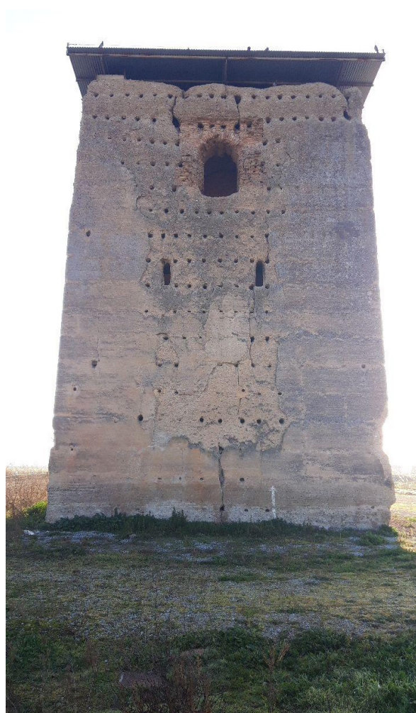
Fig. 2. Torre nazarí de Romilla. Fuente: Elaboración propia.
