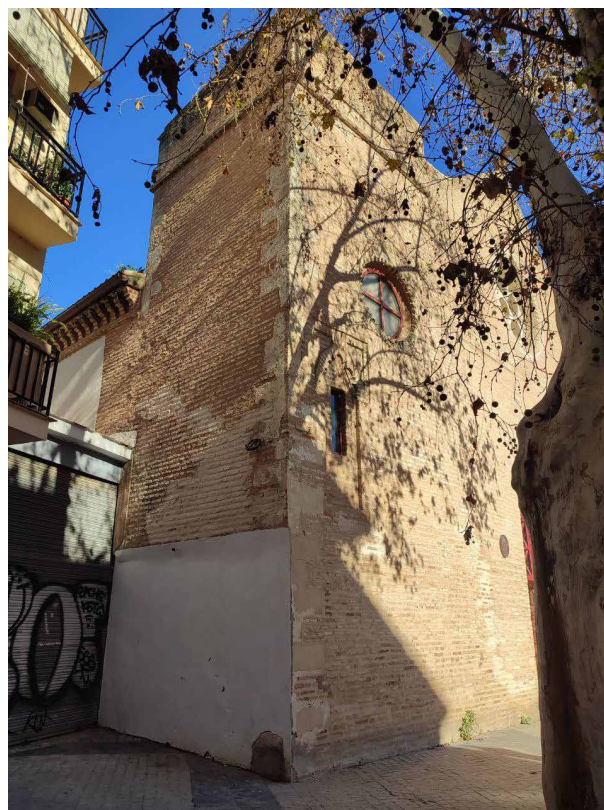
Fig. 2. Vista exterior de la capilla. Fotografía: Autor.
