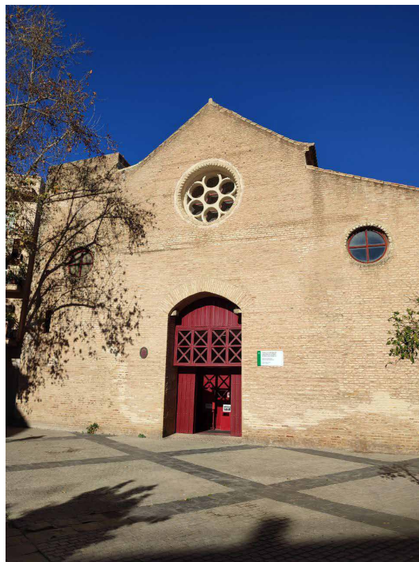
Fig. 6. Fachada principal de Santa Lucía en la actualidad. Fotografía: Autor.
