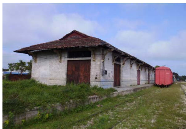
Fig. 1. Cuba Railroad Co. Almacén que forma parte del conjunto de la Estación de Ferrocarril de Manzanillo. Actual provincia Granma. Cuba. 1910. Estado actual. Fotografía: Autores.
