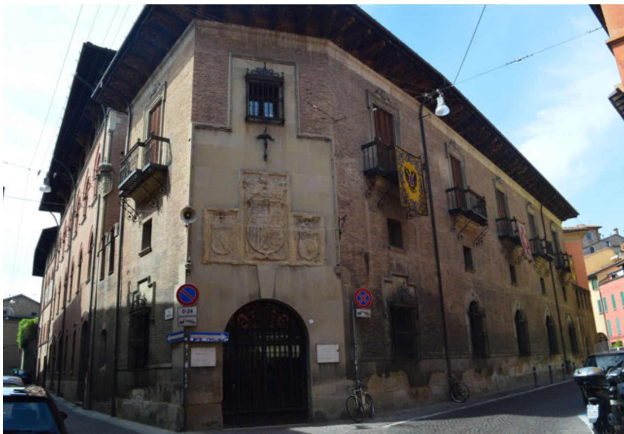
Fig.1. Casa de Cervantes. 1927-1930. Real Colegio de España. Bolonia. Italia. Fotografía: Autores.
