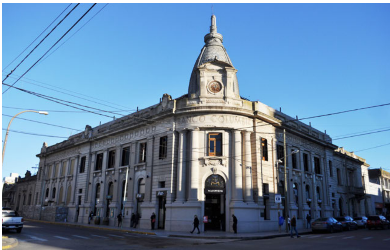
Fig. 2. Ex Edificio Edificadora con modificaciones parciales. Fotografía: Autora.
