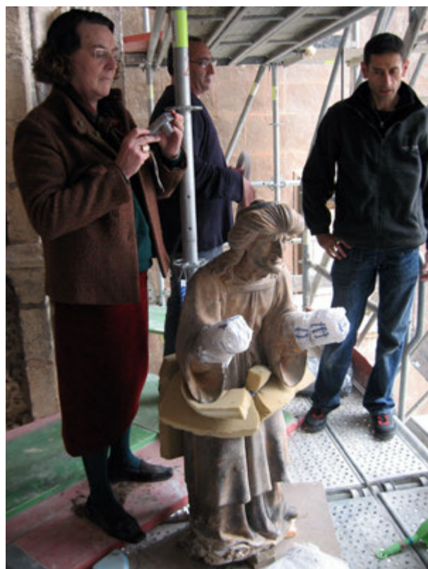
Fig. 5. En el andamio de la restauración de la puerta de la Campanilla con Fernando Guerra-Librero y Ángel Luis García (2006).
