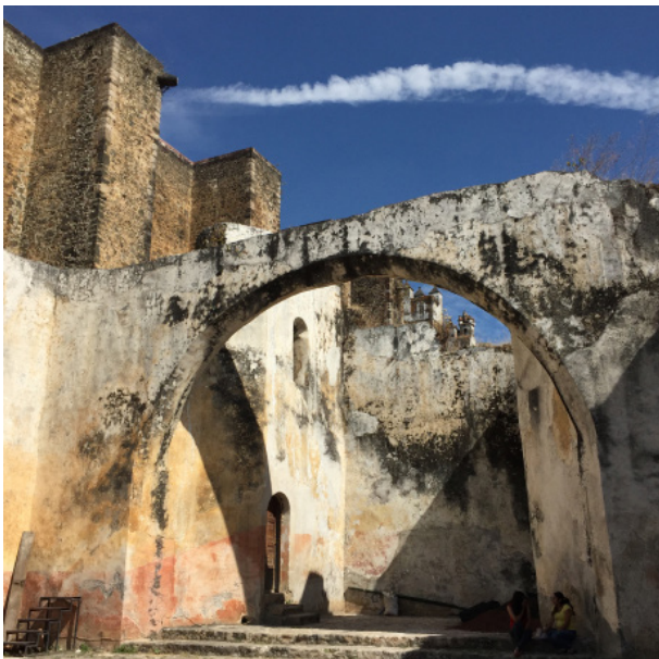
Fig. 2. Capilla abierta. Antigo convento dominico de La Natividad. 1555-1580. Tepoztlán. México. Fotografía de la autora.
