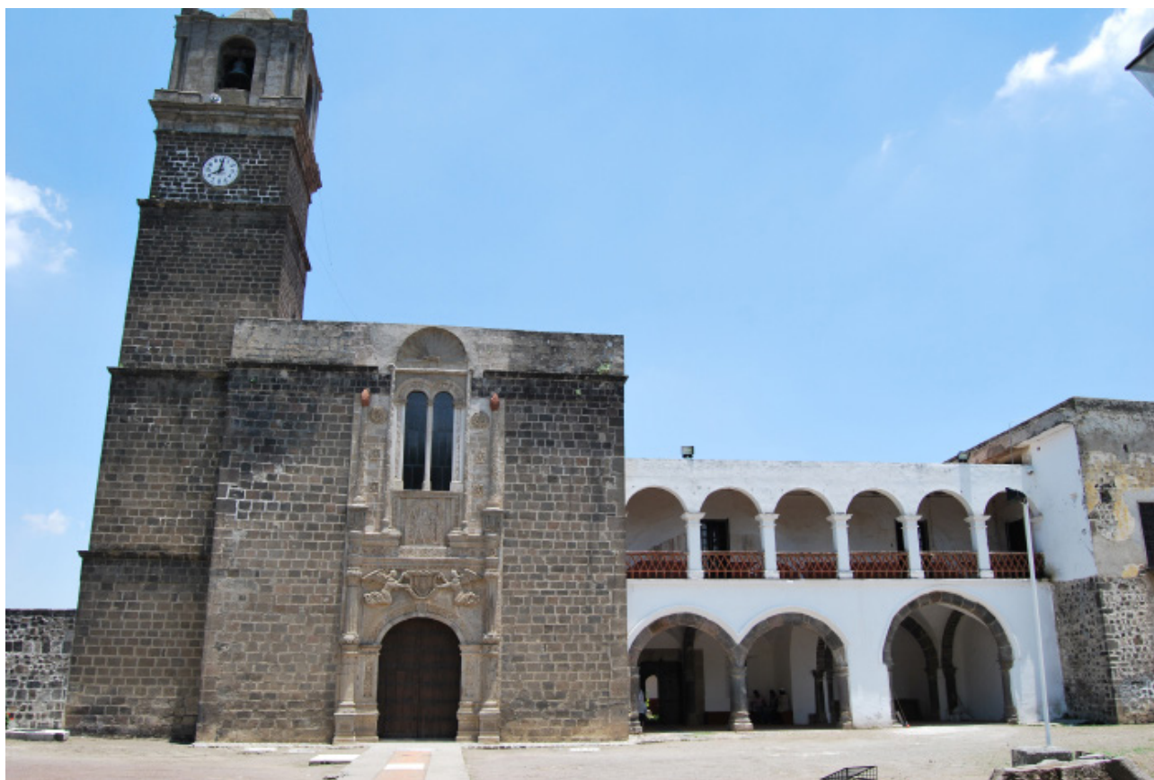
Fig. 1. Fachada, portería y capilla abierta. Antiguo convento franciscano de San Andrés. C. 1548-1555. Calpan. México. Fotografía de la autora.
