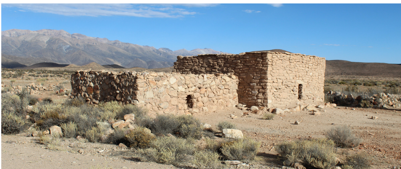
Fig. 1. Vista general del tambo de Zapahuirra. Fotografía: Autoras.
