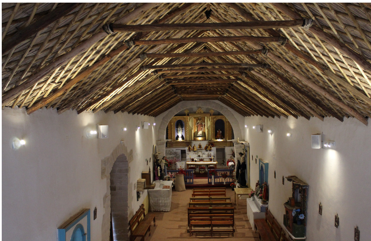
Fig. 6. Detalle interior de la techumbre del templo de Santiago Apóstol de Belén. Fotografía: Autoras.
