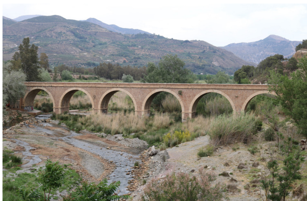
Fig. 8. Puente de Órgiva sobre el Guadalfeo. Carretera de 2.º orden de Tablate a Albuñol. Fotografía: Autores.
