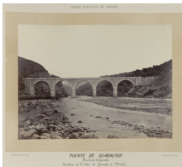
Fig. 4. Juan Martínez Sánchez. Puente sobre el río Guadalfeo en la carretera de 2º orden de Granada a Motril. Fotografía. 1867. École Nationale des Ponts et Chaussées. París, Francia. Copyright École Nationale des Ponts et Chaussées.
