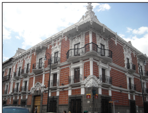
Fig. 7. Argamasas en la portería del Convento de Santo Domingo. Puebla de los Ángeles. México. (Foto: José Antonio Terán Bonilla). (Arriba). Argamasas en la fachada de la Casa de Alfeñique. Puebla de los Ángeles. México. (Foto: José Antonio Terán Bonilla). (Abajo).
