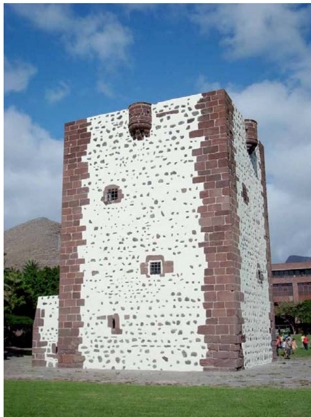
Fig. 3. Torre de los Peraza o del Conde. La Gomera.
