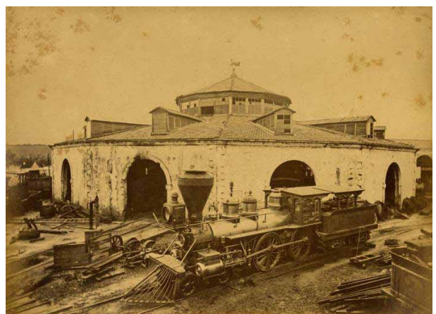
Fig. 4. Casa de máquinas del Ferrocarril de Sabanilla. Cortesía del Dr. Ercilio Vento Canosa, Historiador de la ciudad de Matanzas. Diciembre 2013.
