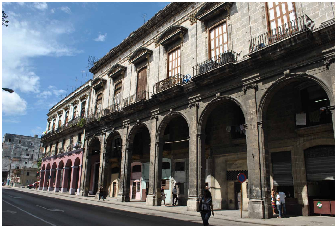
Fig. 8. Edificaciones del reparto Las Murallas en el presente. Foto María Victoria Zardoya.
