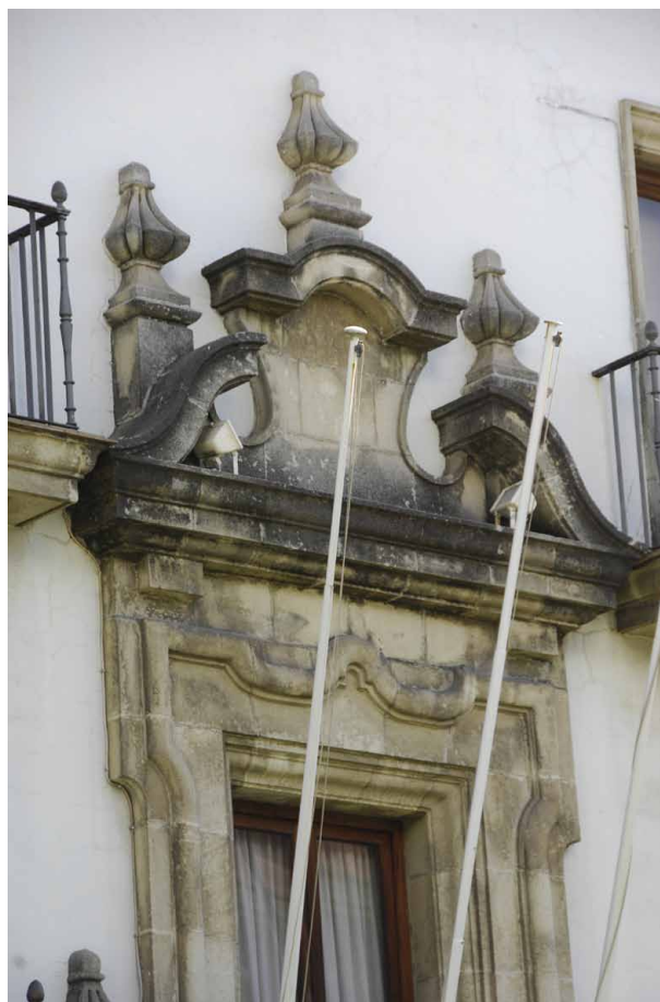
Fig. 2. Detalle de la guarnición de un vano. Edificio de Jerez de la Frontera. Foto de Julio Larramendi.
