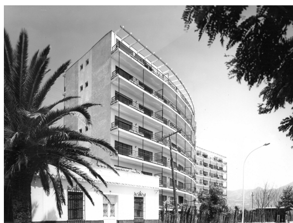
Fig. 2. Antonio García Garrido y Eduardo Ramos. Apartamentos San Miguel. Fuengirola. Fotografía tras su construcción. 1962.
