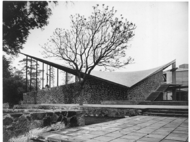
Fig. 6. Félix Candela y Enrique de la Mora. Capilla de Nuestra Señora de la Soledad, “El Altillo. Ciudad de México. Fotografía del exterior en construcción. 1955.
