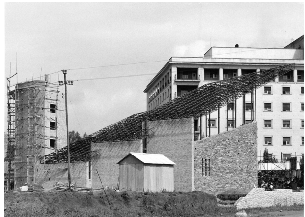
Fig. 7. Antonio García Garrido y Eduardo Ramos. Parroquia de Santa Rosa de Lima. Málaga. Fotografía del exterior en construcción. 1968.
