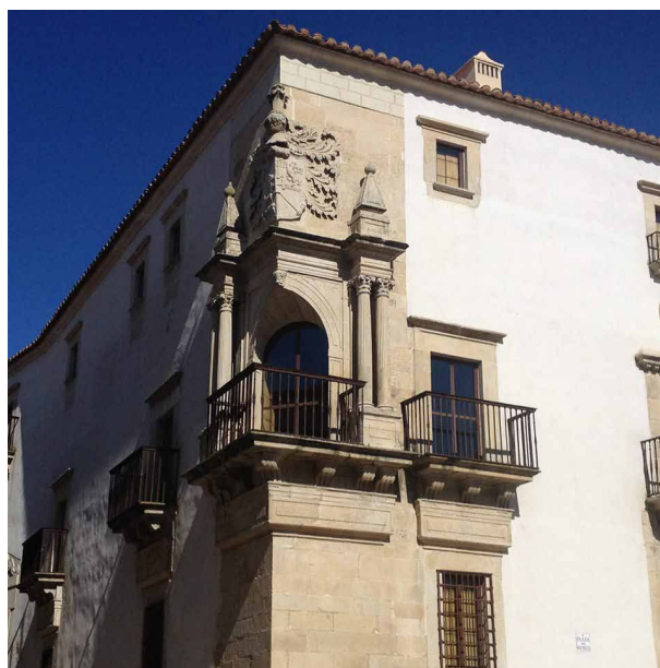
Fig. 1. Palacio Barrantes-Cervantes, sede de la Fundación Obra Pía de los Pizarro. (Foto Y. Fernández)
