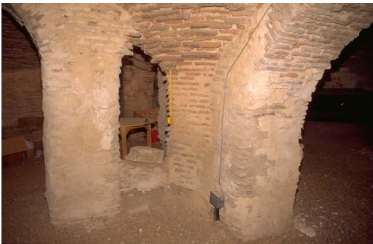
Figura 3. Casa del Greco: sótano bajo la sala de exposición
