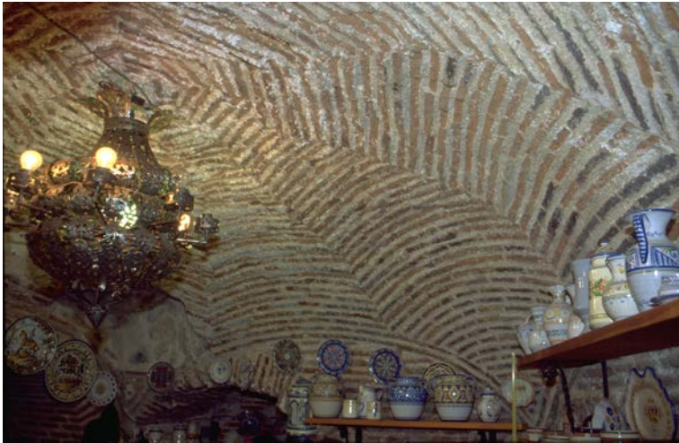
Figura 6. Casa de Bazan (actual calle de San Juan de Dios n° 18): cúpula rebajada sobre colgantes
