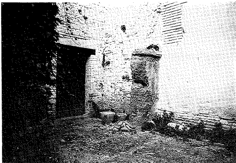
Lám. 5. Restos de muros del jardín bajo medieval.
