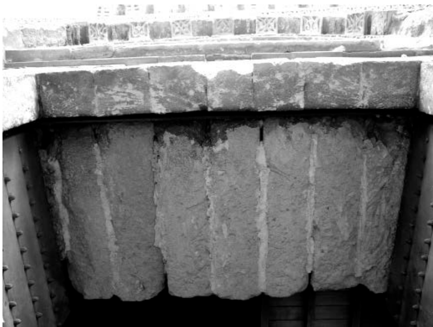
Lám. III: Bāb al-Uzarā'. Dintel interior del siglo VIII, ranura y dintel estrecho de intradós del arco de la reforma de Muḥammad I.
