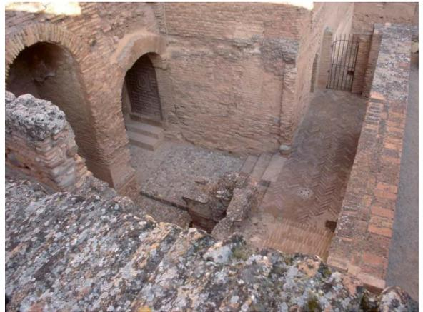
Lám. 16. Puerta de la reforma nazarí con el arranque de la bóveda que lo cubría y jamba del arco, adosados a la torre de la Vela. (Foto C. V., 2009)
