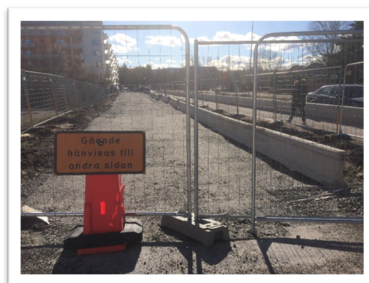
Obras de construcción en la calle Alfred Nobels allé
