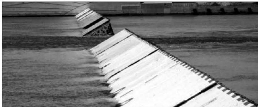
FIGURA 9. Las compuertas del MOSE. Se notan las compuertas defectuosas en el centro
