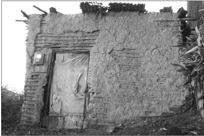
Restos de una casa de bahareque en La Sabana, en donde se observa la antigua forma de construcción de las viviendas
