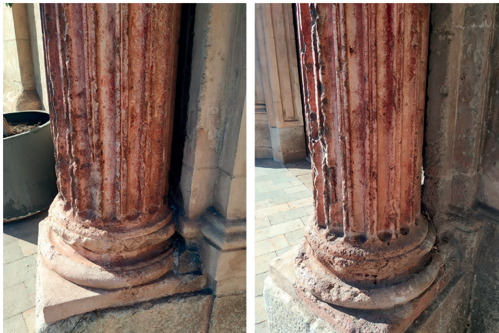
Figura 5. Detalles inferiores de las dos columnas actualmente utilizadas en la fachada de la Iglesia de San Andrés (Murcia). Obsérvense los fustes policromados en rojo, al objeto de enmascarar la mala calidad y el deterioro del travertino. Fotografías del autor.
