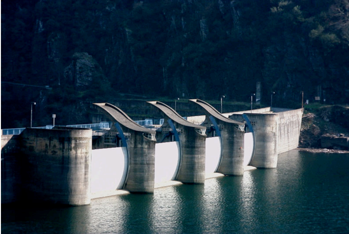
Imagen 10: Salto y central hidroeléctrica de Grandas de Salime, conjunto incluido en el catálogo de referencia del Plan Nacional de Patrimonio Industrial. Fotografía: Natalia Tielve García.
