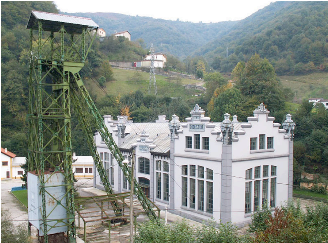
Imagen 7: Pozo San Luis de Carbones de La Nueva en Langreo, sede del Ecomuseo de Samuño desde el año 2013. La impecable rehabilitación de la casa de maquinas es responsabilidad del arquitecto Carlos Marqués. Fotografía: Faustino Suárez Antuña.
