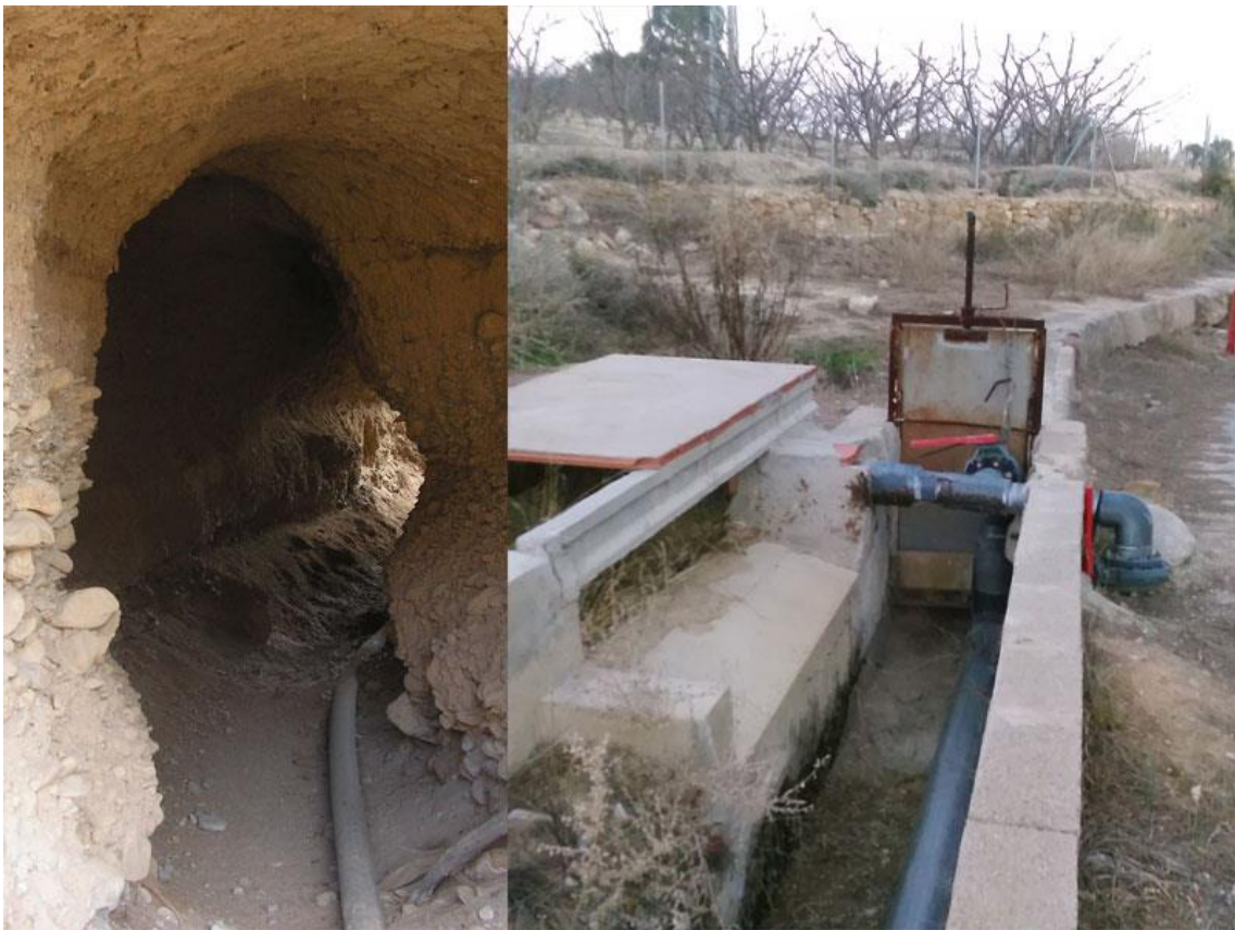
Link 03. Dos ejemplos de aprovechamiento de infraestructuras tradicionales de conducción, para instalar tuberías de distribución presurizadas, dentro del Plan de Modernización de regadíos. Una en un canal a cielo abierto y otro en un tramo minado. Fuente: Elaboración propia.
