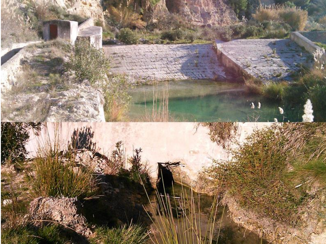
Ilustración 04. Azud o presa de El Gallardo, con la toma o boquera donde se captaban las aguas para la Acequia Mayor, situada en la margen derecha según el sentido de las aguas. Fuente: Elaboración propia.
