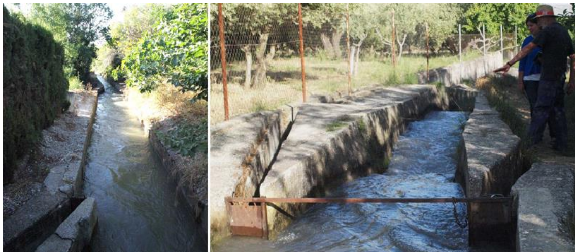
Ilustración 07. Acequia principal de Alhendín e inicio de las acequias séptimas, por las que se deriva una séptima parte del caudal. A la izquierda, acequia primera séptima o séptima alta. A la derecha, séptima del martes y miércoles y séptima del sábado noche. Ana García Leal. 2013.
