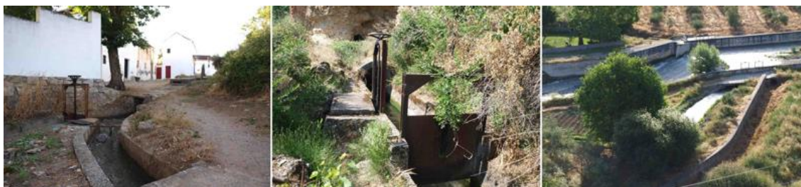
Ilustración 03. Elementos claves para el reparto de aguas entre el día y la noche. A la izquierda, acequia principal de Otura y partididor que deriva las aguas hacia la acequia de Alhendín. En el centro, acequia principal de Alhendín con partididor hacia la acequia de la Cafa. A la derecha, el río Dílar en el punto en el que confluyen la acequia de la Cafa y la nueva presa de Las Gabias. Ana García Leal. 2013.
