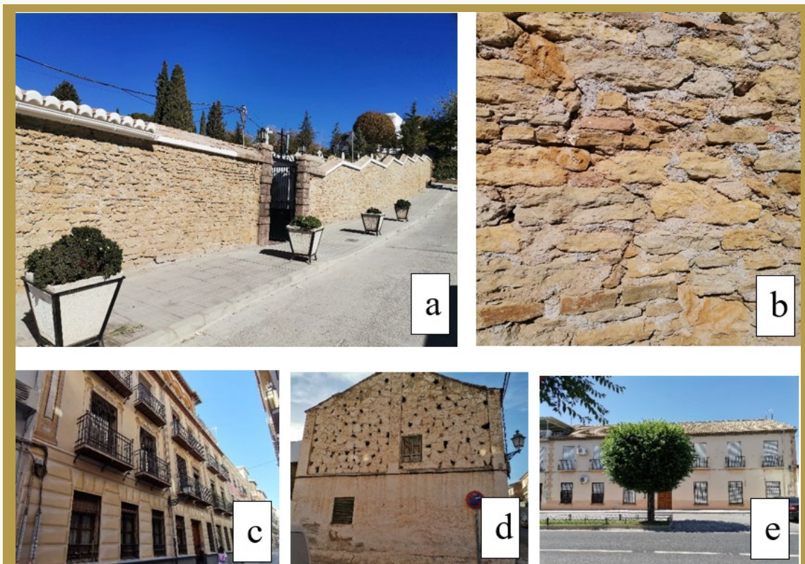
FIGURA 13. Muro de piedra arenisca de la fachada principal del cementerio de Las Gabias (letra a), detalle constructivo de la fábrica del muro de la figura anterior (letra b), edificio de viviendas de dos plantas en calle Buensuceso no 38 en Granada (letra c), lateral de fachada de una vivienda en la calle San Ignacio no 36 de Las Gabias (letra d), viviendas de la calle Progreso no 31 y 33 de Las Gabias (letra e). Autor: L. Alcoba Rodríguez.
