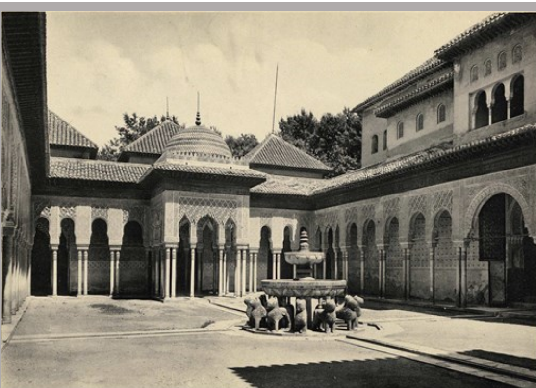
Imagen 7. Patio de los Leones, esquina sureste. Cubiertas de la galería sur restauradas conforme la obra de 1872. Se observa la impronta de la altura del faldón preexistente en el muro del corredor de la Sala de Abencerrajes. STENDEL & CO (DRESDEN), 1905. En http://catalogo.bne.es/uhtbin/cgisirsi/0/x/0/05?searchdata1=a4453049
