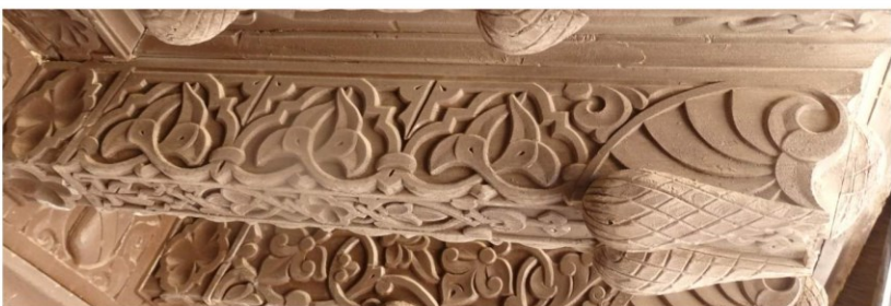
Imagen 16. Tipos y disposición de canecillos en los aleros del Patio de los Leones (Nomenclatura A, B, C y D consensuada por el equipo que ha participado en las obras de restauración). Fuente: M a Teresa Gómez, 2016-17.
