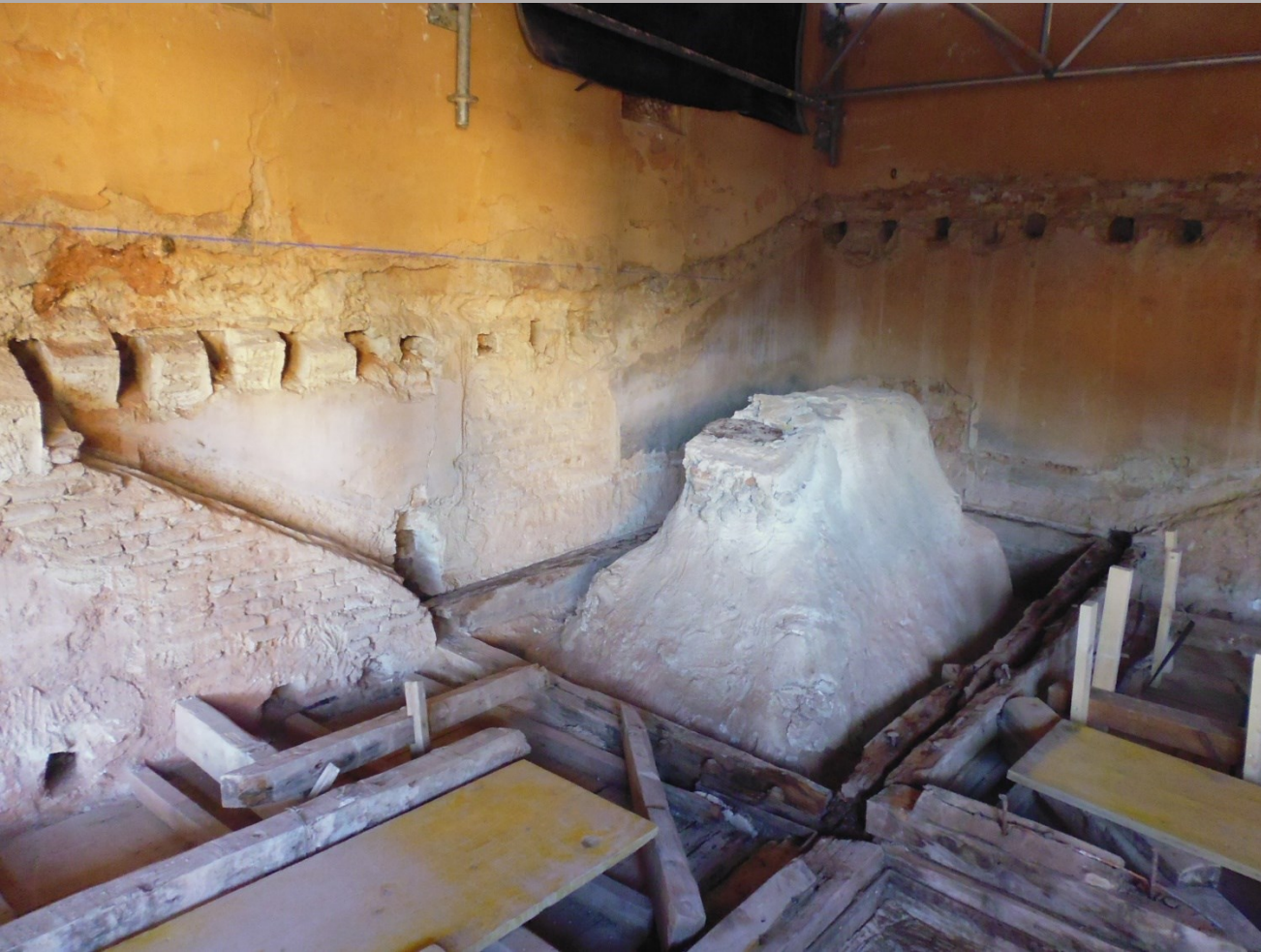
Imagen 11. Bóveda de mocárabes bajo la esquina suroeste de las cubiertas de la galería del Patio de los Leones. Se observa que la estructura se encuentra rodeada de un sistema de estribos para recoger la armadura y las canales correspondientes al pabellón construido. Fuente: M a Teresa Gómez, 2017.
