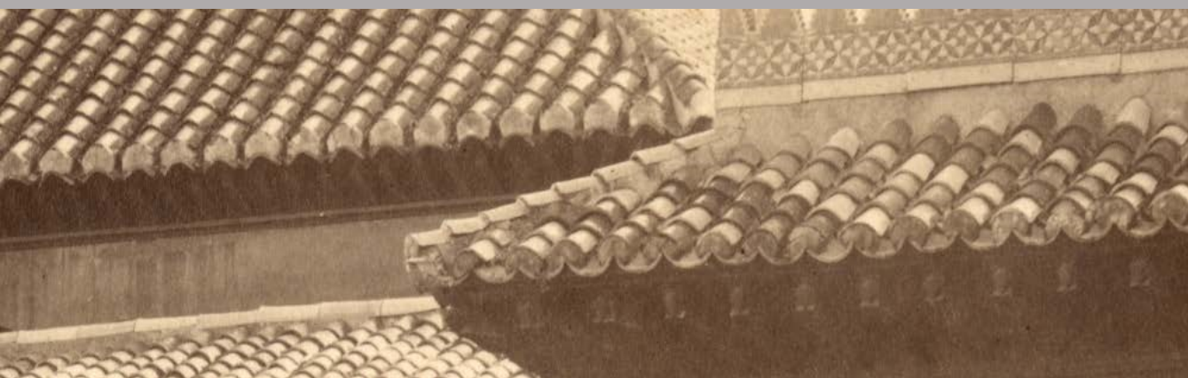
Imagen 4. Obras en las cubiertas de la galería norte del Patio de los Leones. Detalle de las dos formas de rematar los tejados, a la izquierda bocateja "a la granadina" en la Sala de los Reyes, a la derecha bocateja "a la malagueña" en el templete de levante. Patronato de la Alhambra y Generalife, Archivo, Colección de fotografías, F-13207.
