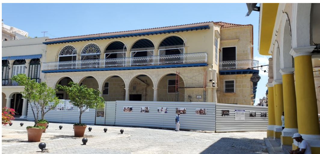
Ilustración 3. Antiguo Palacio de los Condes de San Juan de Jaruco y Santa Cruz de Mopox en la Plaza Vieja. El inmueble a inicios de los ochenta albergó la sede de la Escuela de Museología y actualmente se encuentra en proceso de restauración. Elaboración propia.
