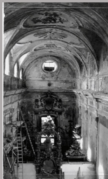
Imagen 7. Estado ruinoso de la Iglesia de Santa María de El Paular tras la Desamortización. Fuente: BARCELÓ, E. (2013). La recuperación del Paular, Madrid: Secretaría General Técnica. Centro de Publicaciones. Ministerio de Educación, Cultura y Deporte, 42.
