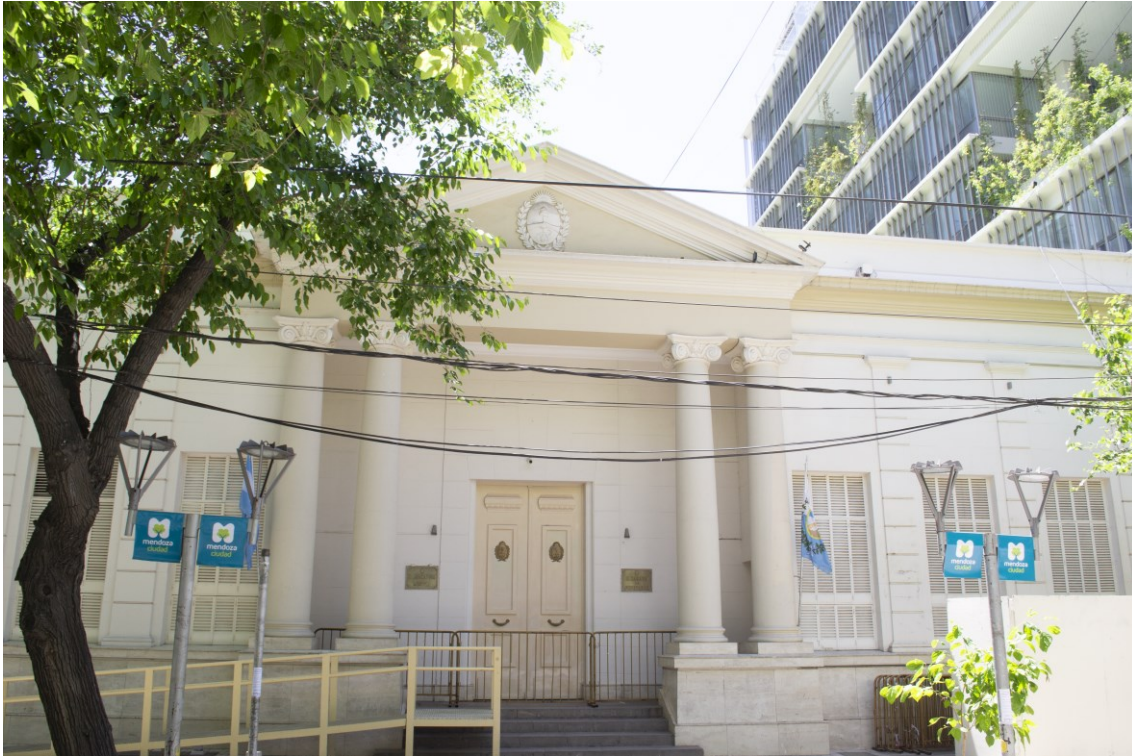
Ilustración 1. Fachada de Edificio Legislativo de la provincia de Mendoza y Anexo. Autora: Marina Mercado. Con permiso para su publicación en erph.
