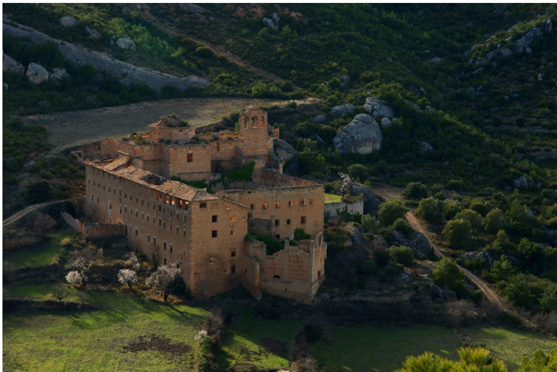
Ilustración 4. Convento del Desierto de Calanda (Teruel). Siglo XVIII. Urge un censo sobre el estado de conservación de la arquitectura conventual en nuestra región. Archivo fotográfico de la Comarca del Bajo Aragón. Con permiso para publicación en erph.
