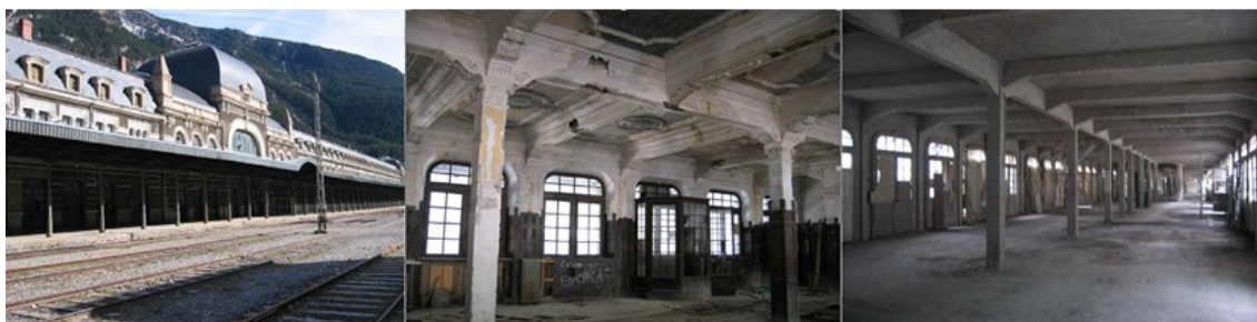
Ilustración 7. Estación internacional de Canfranc (Huesca), 1928. BIC. El proyecto de “restauración” modificó la estructura exterior y supuso su completo vaciado interior; imágenes tomadas en 2005 y 2006. Autor Apudepa. Con permiso para publicación en erph.
