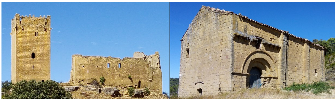
Ilustración 2. Castillo y ermita románica de Yéquera, Luna (Zaragoza), BIC. Muestra del estado de conservación de bienes integrantes de nuestro patrimonio románico y gótico. Autor Apudepa. Con permiso para publicación en erph.
