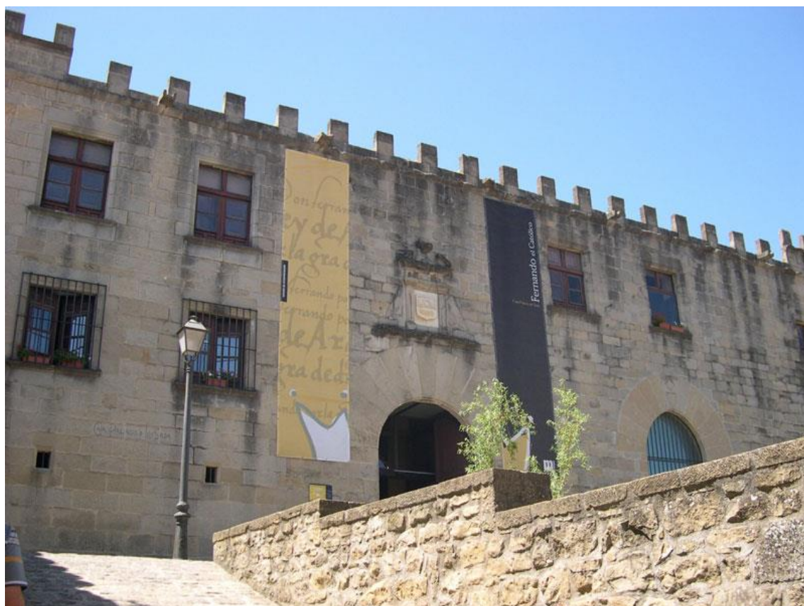
Link 02. Palacio de los Sada. Estado actual. Fotografía de las autoras.
