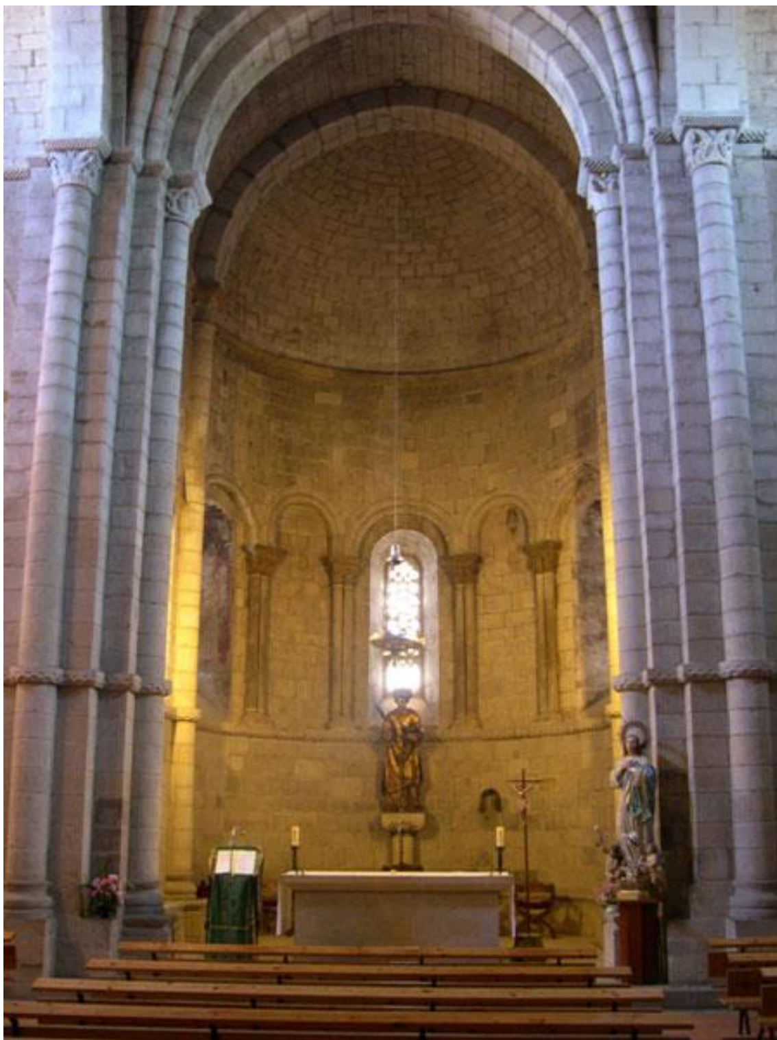
Link 07. Iglesia de San Esteban. Detalle del ábside principal, estado actual. Fotografía de las autoras.
