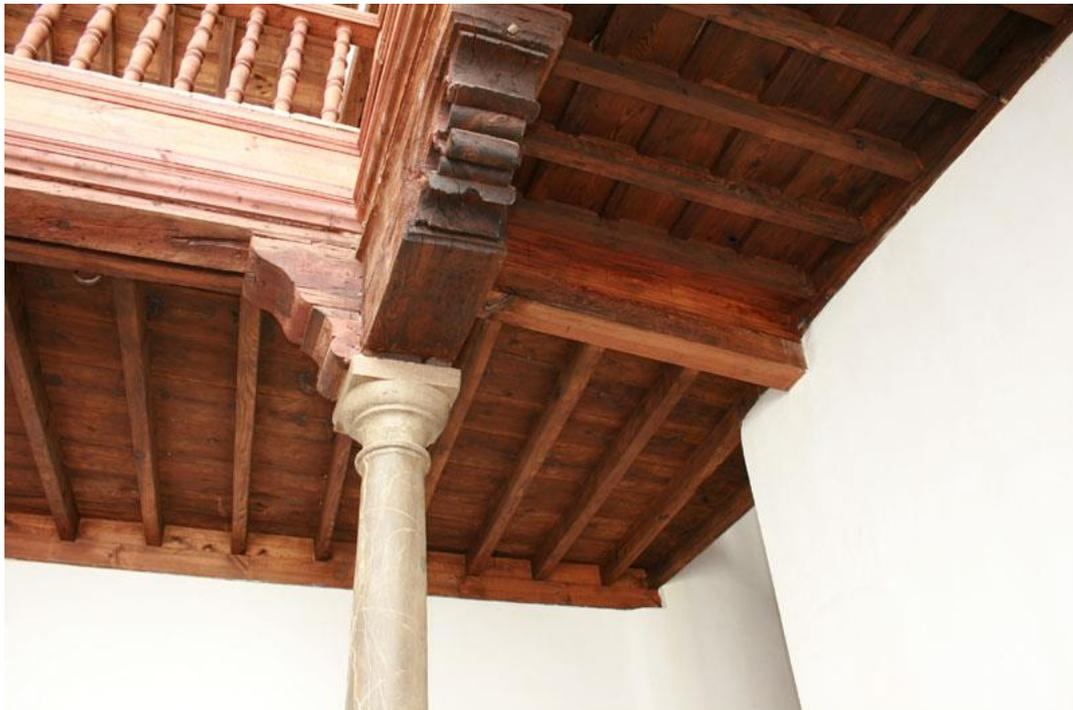
Link 05. Casa situada en la Cuesta de Arremangadas nº 6, patio. Detalle de unión de zapatas que sostienen las jácenas de los pórticos norte (en el lado derecho) y oeste, sobre la columna de piedra de la esquina noroeste. Nótese sus diferencias. Fotografía de la autora, año 2010.
