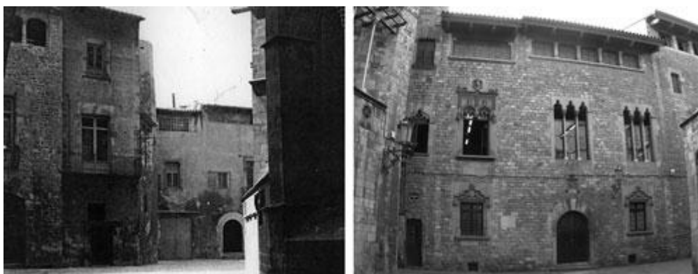
Ilustración 08. Fachada principal de la Casa de los Canónigos antes y después de la restauración, realizada por Jeroni Martorell entre 1927 y 1930
