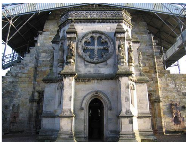
Ilustración 02. Rosslyn Chapel, Escocia. Fachada principal. Exterior de la capilla, con la estructura de andamiajes visitable de protección de la cubierta pétrea.
