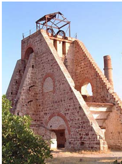
Ilustración 13. Cabria de mampostería Pozo San Vicente (Cia. La Minera).
