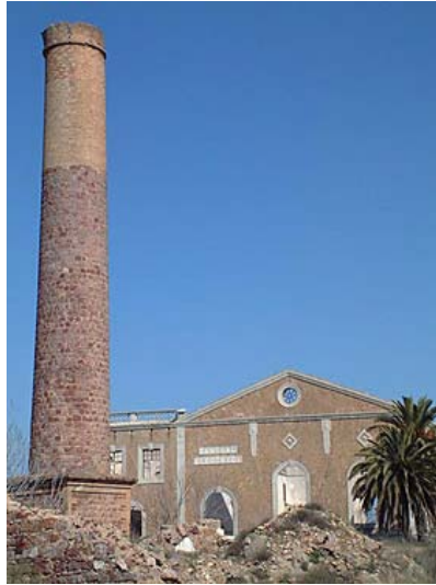
Ilustración 15. Central eléctrica del Pozo San José (Mina Arrayanes).
