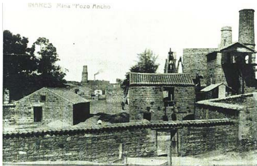
Ilustración 6. Mina Pozo Ancho.
