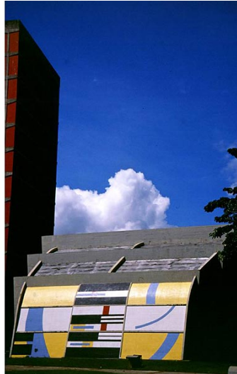
Link 17. Manaure, Mateo (1926) Sin Título. (1954) Reconstruido (1985) Mural. Cerámica esmaltada. 640 x 1465 cm. Edificio de la Sala de Conciertos. Fachada este. Foto: Juan Pérez Hernández, Caracas, 2000
