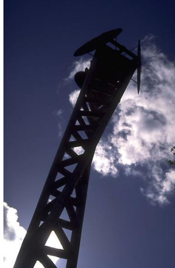
Link 33. Reloj Universitario. Anexo al Edificio de Museo. Ciudad Universitaria de Caracas. Foto: Juan Pérez Hernández, Caracas, 2000
