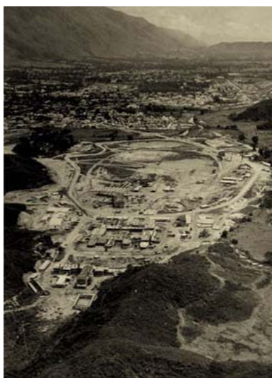
Portada. Vista aérea oblicua de la Ciudad Universitaria de Caracas – Primera Etapa Constructiva. Foto: S/a., S/f. Referencia: Archivo del Instituto Ciudad Universitaria. Caracas.
