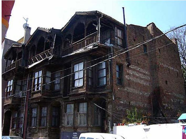
Ilustración 3. Casas enfiladas, o rowhouses, en pésimo estado en el barrio de Fener. Construidas por la pequeña y media burguesía, unen las tradiciones de la construcción en madera con el empleo del ladrillo y la repetición de fachadas de influencia europea.
