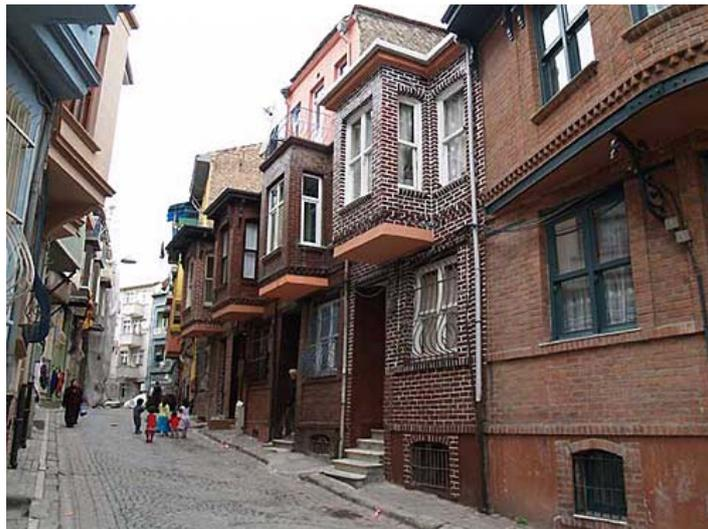
Ilustración 4. Rowhouses en el barrio de Balat. Construidas en ladrillo, mantienen las fórmulas de la arquitectura otomana de madera. Han sido recuperadas con diferentes soluciones, desde las correspondientes al programa oficial Fener-Balat, a las iniciativas privadas.
