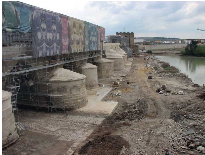
Link 8. El puente romano de Córdoba durante su restauración.
