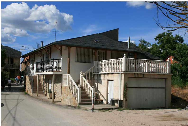
Link 10. Ejemplo de nueva construcción en Las Médulas.
