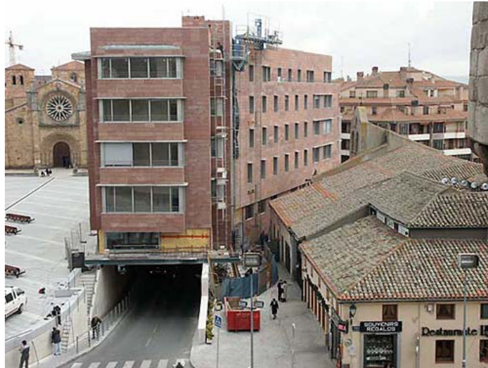
Ilustración 5. Vista de la entrada al aparcamiento bajo la plaza de Santa Teresa desde las murallas, Ávila
