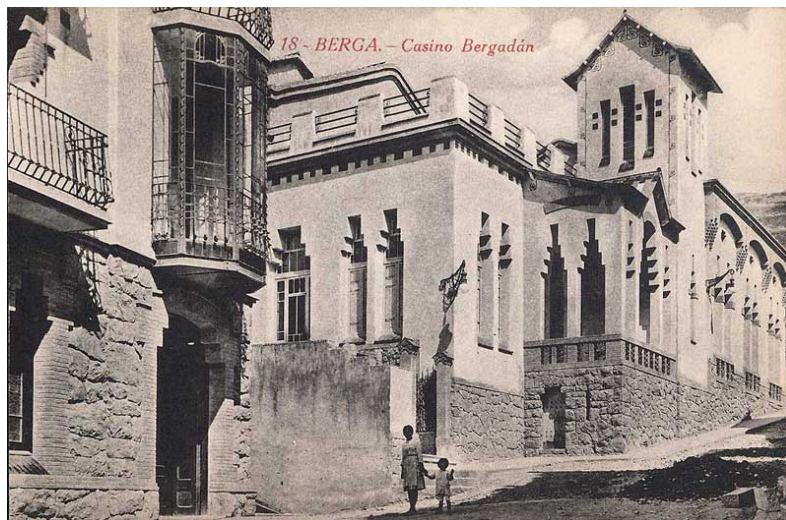
Link 17. BERGA (Barcelona). Antiguo Casino Bergadán. Actualmente, el edificio es casi irreconocible. Fototipia Castañeira, Álvarez y Levenfeld, Madrid.
