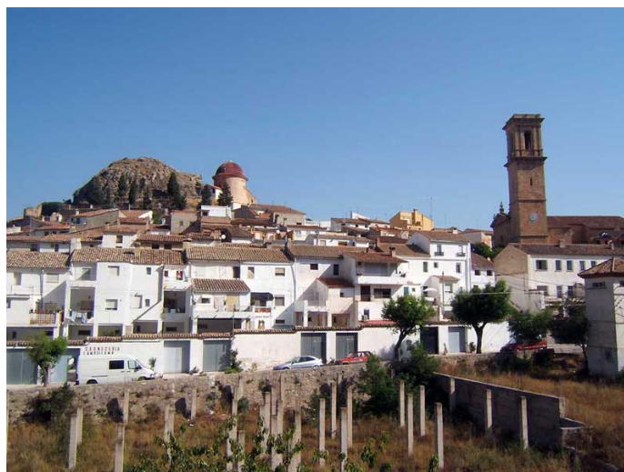
Link 16. ANDILLA (Valencia). Bajo el volumen compacto del pueblo, poco transformado aún, se levantan los pilares de una obra sabiamente interrumpida que pretendía crecer en medio del barranco. Foto R. Lacuesta, agosto 2007.
