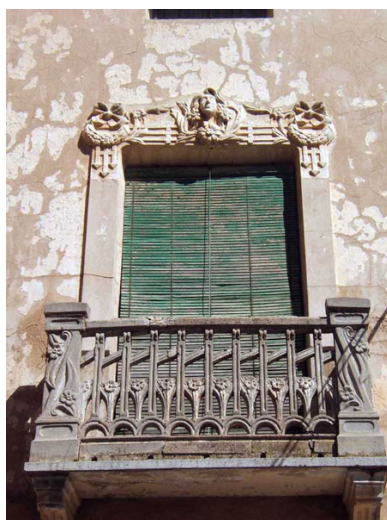
Link 11. CASAS IBÁÑEZ (Albacete). Detalle una casa modernista, de influencia secesionista, construida frente a la iglesia parroquial, en el casco antiguo. Ostenta un cartel de próxima demolición. Foto: F. Balaña, agosto 2007.
