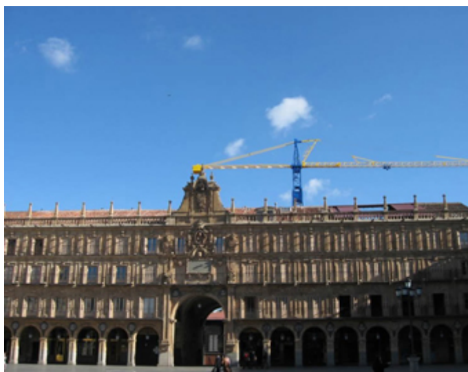
Ilustración 7. Reparación de las cubiertas de la Plaza Mayor de Salamanca.
