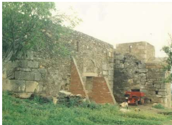
Ilustración 7. Vista de los muretes de arriostramiento mantenidos hasta la última restauración. Fotografía inédita cedida por el Constructor, Antonio ABREU.
