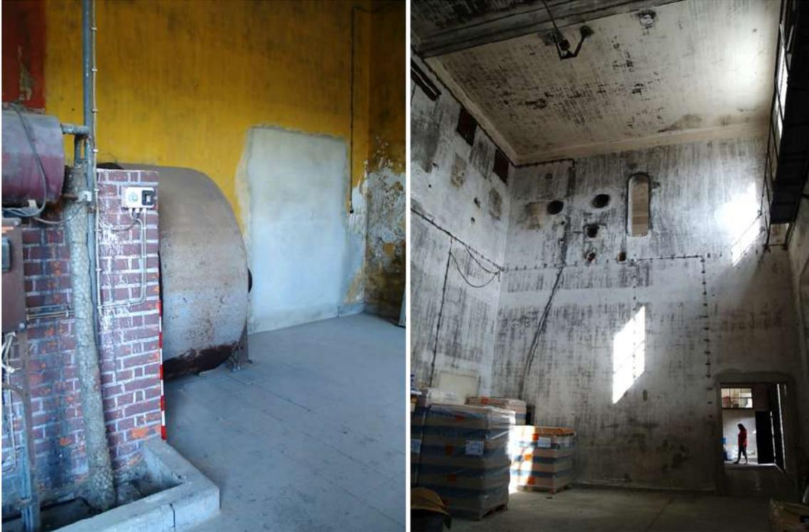
Ilustración 2. Accesos cerrados: a la izquierda la sala de calderas, y a la derecha la sala de secado de arroz, en la que la caldera inyectaba aire caliente. Con el cierre de la fábrica, y la refuncionalización del espacio como almacén, se taparon los pasillos que antes permitían el paso entre ambas salas, y se eliminaron los secadores para permitir el nuevo uso. Elaboración propia.
