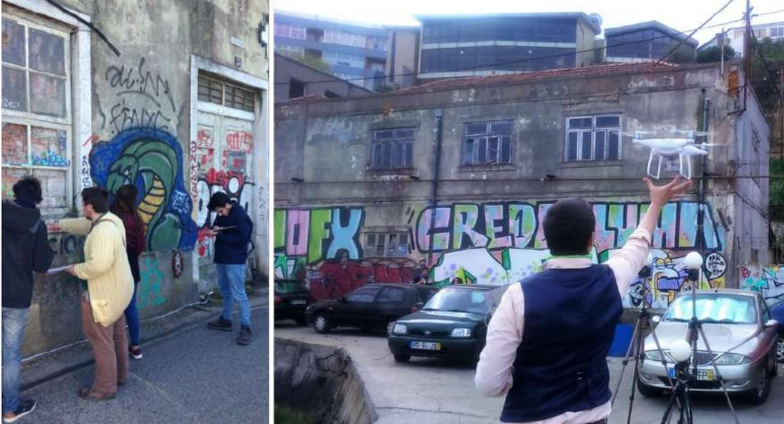
Ilustración 4. A la izquierda, el levantamiento manual del alzado realizado por alumnos de la NOVA FCSH, y a la derecha el levantamiento fotogramétrico realizado con dron, que han permitido evaluar y criticar los puntos fuertes y débiles de ambos enfoques. Elaboración propia.
