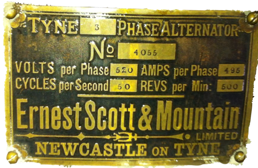
Ilustración 12. Placa de características del generador. Elaboración propia.
