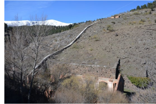
ILUSTRACIÓN 10. CASA DE MÁQUINAS, TUBERÍA FORZADA Y CÁMARA DE CARGA FOTOGRAFÍA DEL AUTOR
