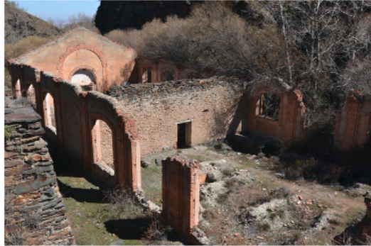
ILUSTRACIÓN 9. CASA DE MÁQUINAS, FOTOGRAFÍA DEL AUTOR
