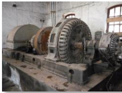
Imagen 13: Turbina y generador. Fotografía del autor.
