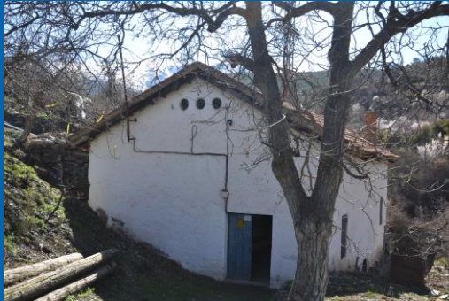
Imagen 3: Casa de Máquinas, Urrutia. Fotografía del autor.
