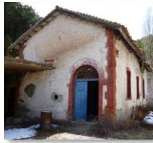
Imagen 14: Casa de máquinas. Fotografía del autor.
