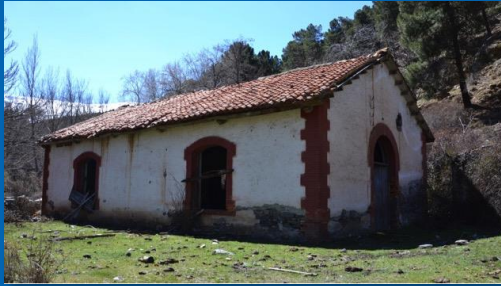
Imagen 7: Casa de Máquinas, Alcázar. Fotografía del autor.
