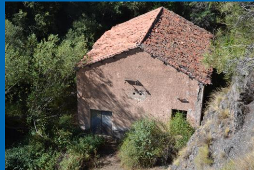
Imagen 4: Casa de Máquinas, Alhorí II. Fotografía del autor.
