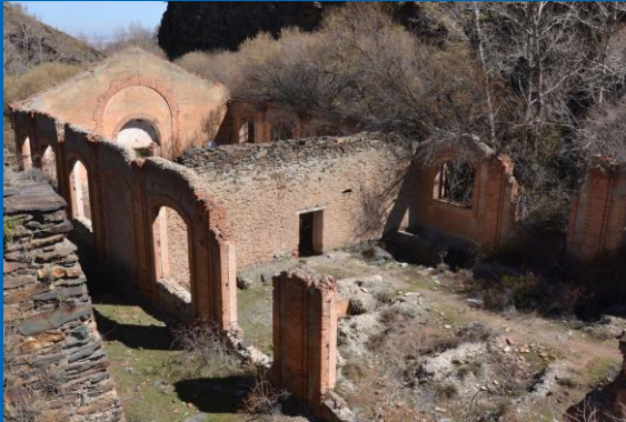
Imagen 9: Casa de máquinas de la Central de aire comprimido ,estado actual 2018. Fotografía del autor.
