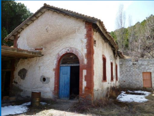
Imagen 5: Casa de Máquinas, Alhorí I. Fotografía del autor.
