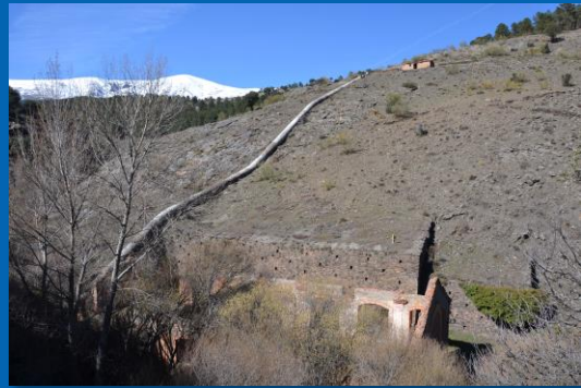
Imagen 10: Casa de máquinas, tubería forzada y cámara de carga. Fotografía del autor.
