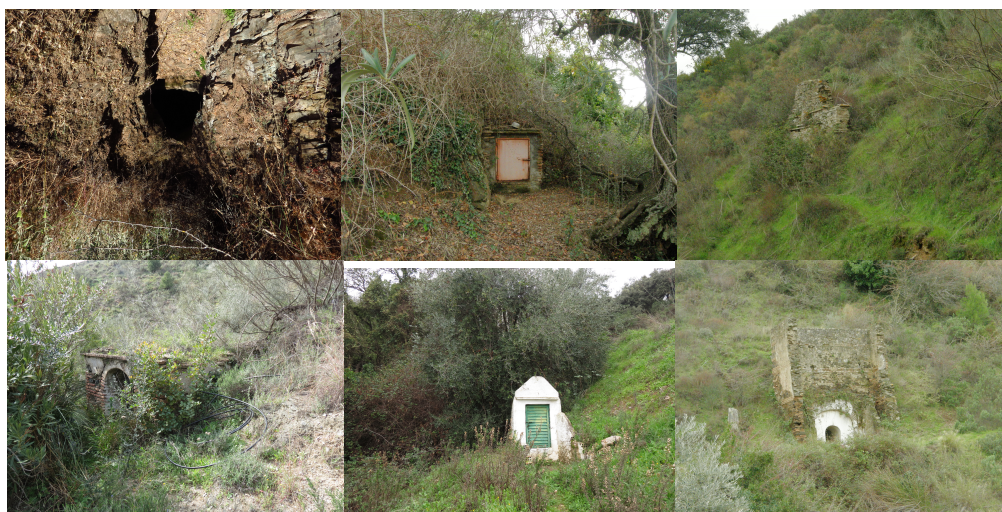
Ilustración 5. Tipos de bocaminas: (a) Bocamina abierta en la roca sin ningún tipo de tratamiento (finca Jiménez), (b, c) Bocamina cerrada con tabique (finca Rubira el Viejo, b) y con función de muro de contención (finca Rubira el Nuevo, c), (d, e) Bocamina de tipo caseta (finca Camino de la Encina, d), (finca El Herrador, e), (f) Bocamina de tipo alcubilla (restos de la alcubilla del lagar de Rubira el Nuevo). Fuente: Imágenes de los autores.
