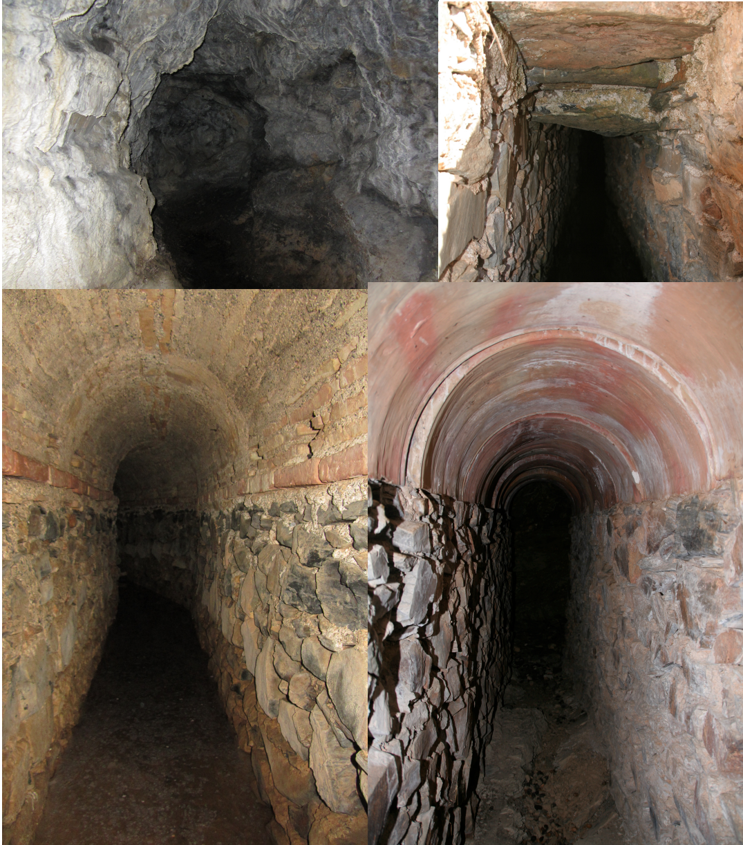
Ilustración 3. Materiales de los paramentos y techos: (a) Mina con paredes y techos sin revestir, construida en roca caliza (finca Linares), (b) Mina con paredes y techo adintelado de mampostería (finca Molino de Viento), (c) Mina con paredes de mampostería y bóveda de cañón de ladrillo (finca Pro de Abajo), (d) Mina con paredes de mampostería y bóveda de cañón de arcos de cerámica (finca Jiménez). Fuente: Imágenes de los autores.
