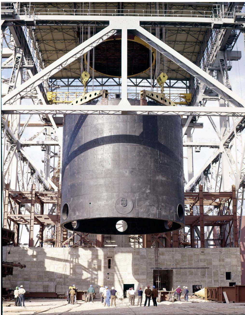
Ilustración 9. Fotografía de la construcción del edificio de contención del reactor. Camisa metálica interior (ref. 10449, 14-10-1969). Fuente: Archivo Municipal de Vandellòs.
