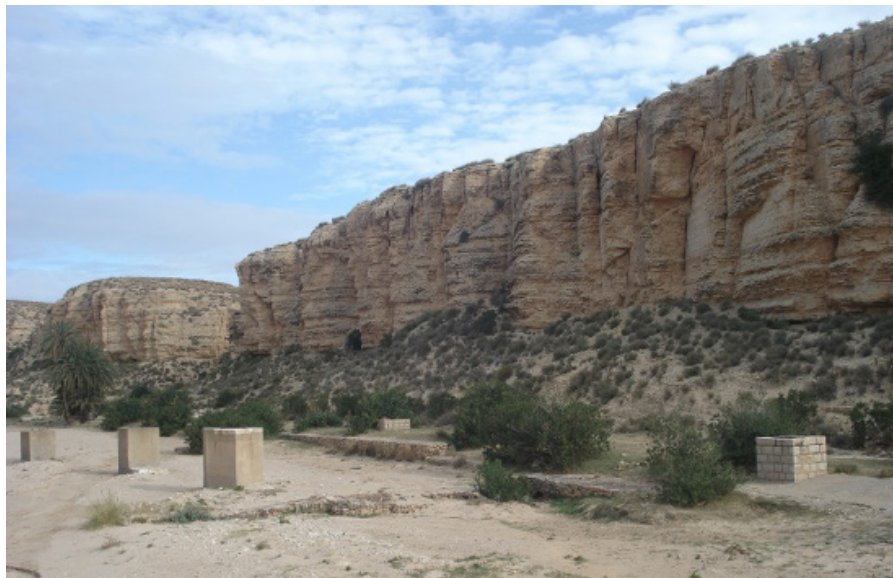
Figura 6: Oued Sbeitla. Obsérvese la bifurcación, que se adentra en el Oued , de la galería de Ain Oued Sbeitla con sus lumbreras pentagonales aproadas a la dirección del flujo.
