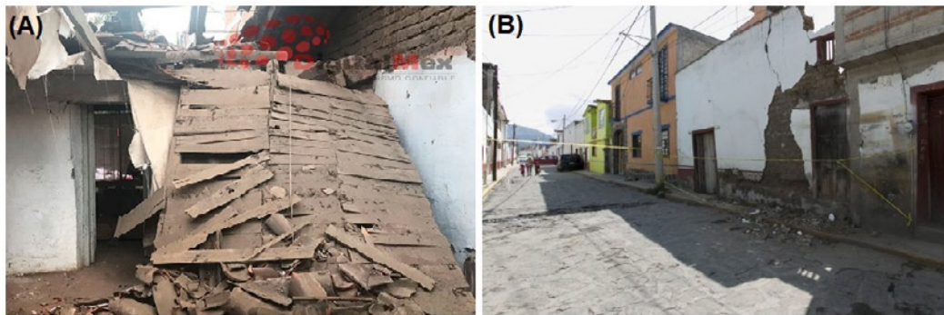
Figura 6. Daños ocasionados en los municipios de Tenancingo y Tenango en viviendas precarias de muros de adobe con techos de madera y teja. Terremoto de magnitud 7,1 que tuvo su epicentro en el Estado de Puebla el 19 de septiembre del 2017.
